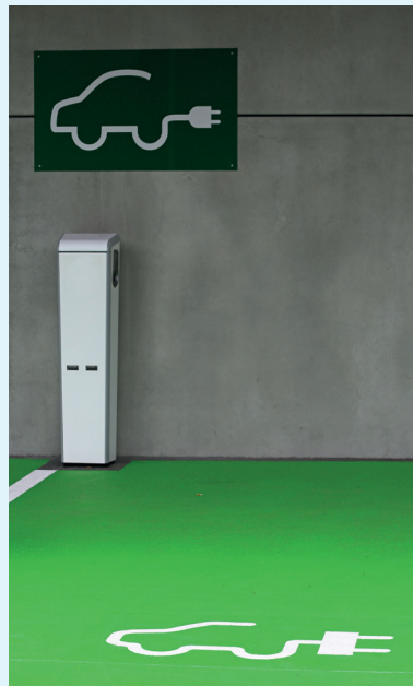
Neue und sanierte Gebäude müssen künftig für E-Auto-Ladeinfrastruktur vorbereitet sein.
